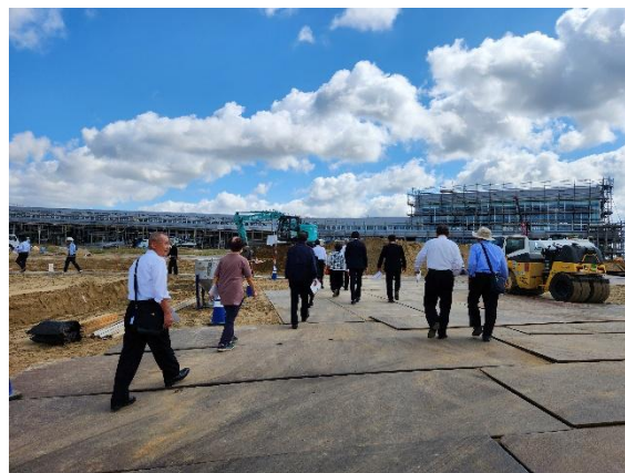
工事現場見学の様子
